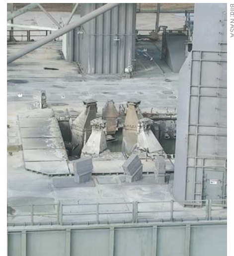
An dieser Stelle treffen die rund 1.650 Grad heißen Abgase der Feststoffbooster auf die Plattform des Mobile Launcher
